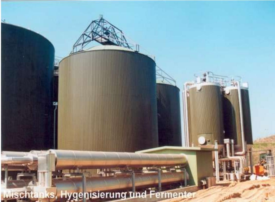
Биогазовые установки представляют собой строительные объекты, состоящие из герметичных реакторов, оснащенных комплексом систем подачи сырья, подогрева, перемешивания, канализации.
