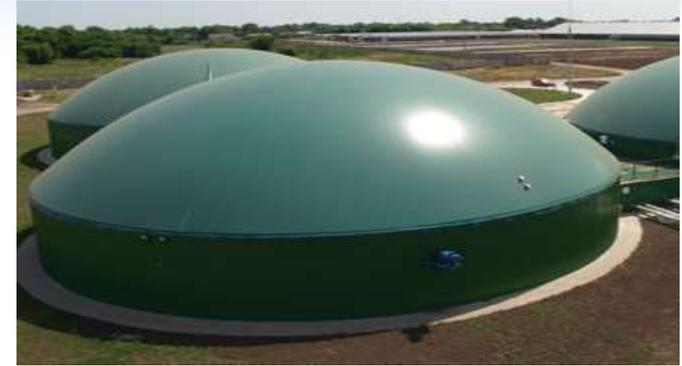
Газгольдер - хранилище биогаза. Он герметично крепится сверху реактора. Внешний купол-чехол из PVC со специальными добавками имеет стойкость к ультрафиолетовому излучению и атмосферным осадкам. Внутренний купол натягивается под действием вырабатываемого биогаза. Между внешним и внутренним куполами закачивается воздух для создания давления на нижний купол, а также для придания формы внешнему. Давление биогаза внутри газгольдера составляет от 200 до 500 Па.
